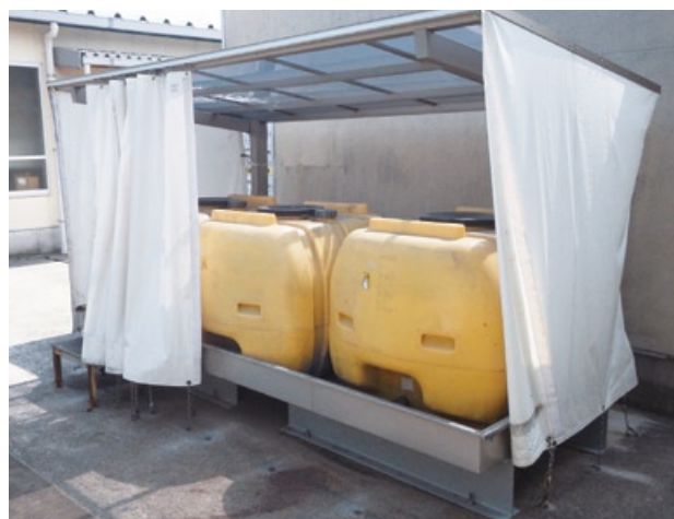
久留米工場貯蔵施設
