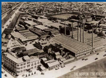
1933～1939年 工場大改造 コンベアやトンネル窯を導入し流れ作業による合理的な量産体制を整えたほか、陶磁器業界では日本で初めて燃料を石炭からガスに転換して煤煙問題を解消。耐震性も高め、作業環境を大幅に改善しました。
