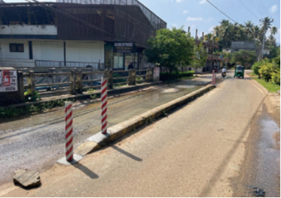
車線分離標の設置
