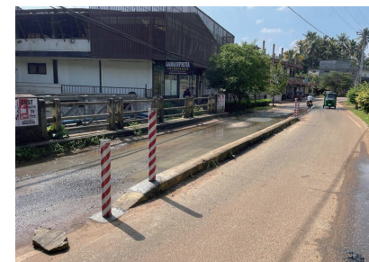
車線分離標の設置
