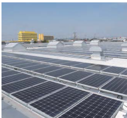
太陽光発電設備(小牧工場) Solar power generation facilities
